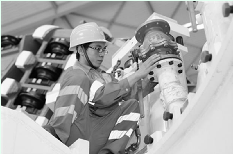
该校盾构施工技术专业学生在签约单位顶岗实习
