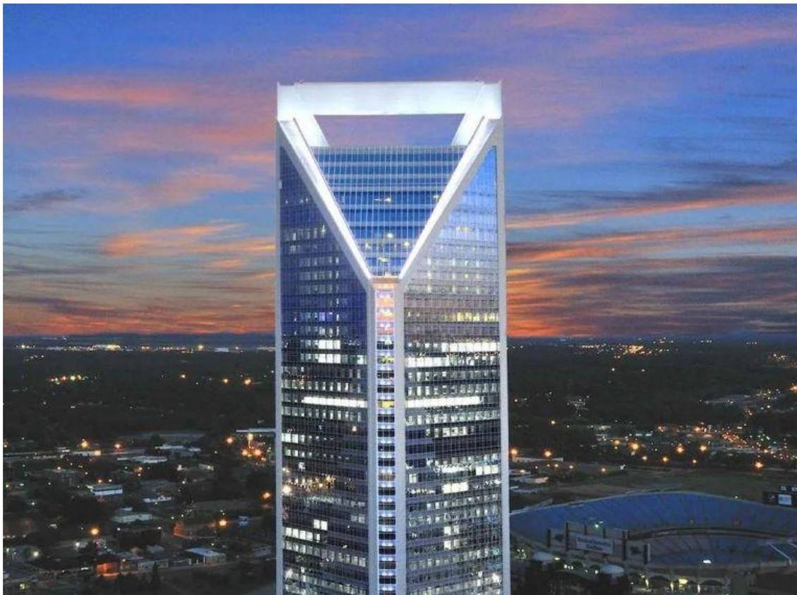
该建筑每年能够再利用大约 1000 万加仑的采水，包括地下水，雨水和 HVAC 冷凝水，满足大约 80% 的冷却塔水需求和 100% 的灌溉需求。有一个**景观美化的屋顶花园**，可减少雨水径流并利用植物吸收多余的热量。日光收集百叶窗随着太阳的角度移动，以将光反射到更深的内部，从而提供更多的自然光。建筑物的外观看起来像是切割后的水晶，并包括超过 45,000 个 LED 灯，在夜间点亮建筑物。
