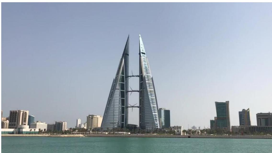
更令人瞩目的是在 50 层、高 240 米的办公塔楼之间安装了 3 台水平轴发电风车，使世贸中心成为世界上首先为自身持续提供可再生能源的摩天大楼。这 3 台发电风车每年约能提供 1200 兆瓦时 (120 万度) 的电力，大约相当于 300 个家庭的用电量。
