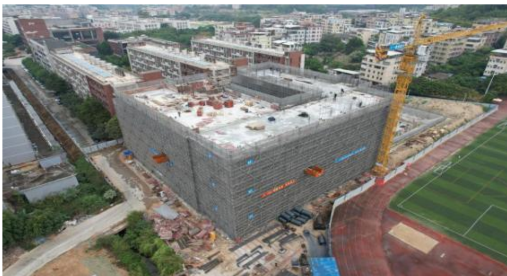
图 92 广州校区新建学生宿舍施工现场
