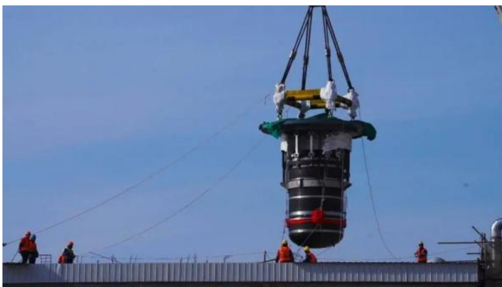
钍基熔盐堆堆本体吊装。中国科学院上海应用物理研究所供图
